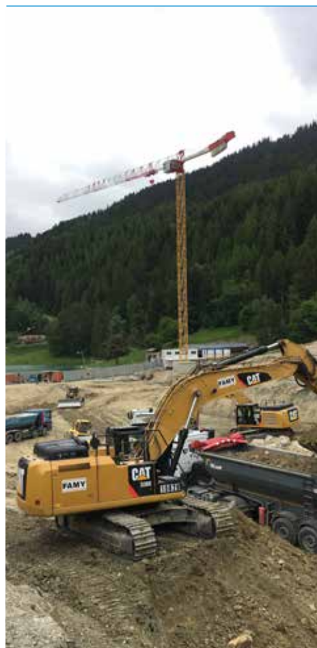
Des visites du chantier seront proposées cet automne.
