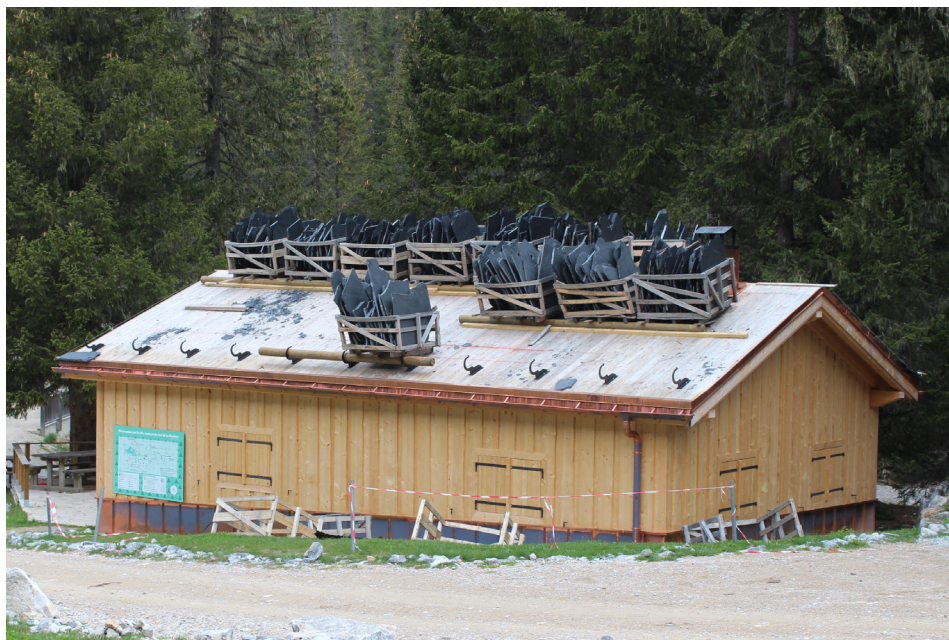
Derniers travaux au chalet d'accueil avant l'ouverture estivale !
